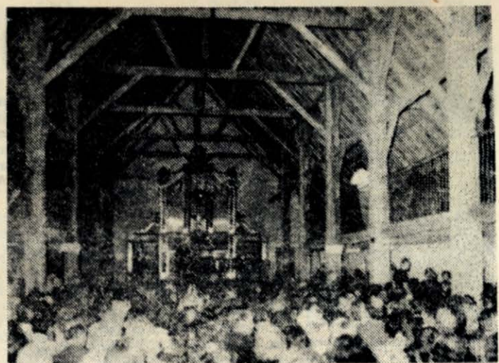
Pohľad na Grange de la Bernardie
